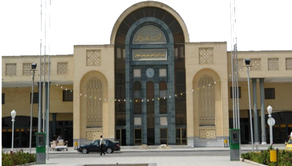
پایانه پروازهای داخلی فرودگاه شهید بهشتی
