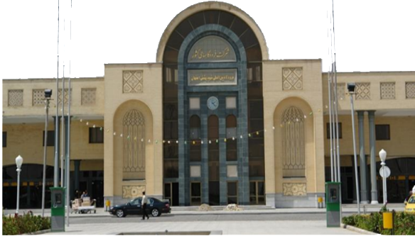
پایانه پروازهای داخلی فرودگاه شهید بهشتی
